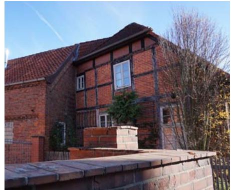
Ziegelsteinmauer vor Hoffläche
