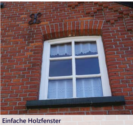
Holzfenster mit Segmentbögen
